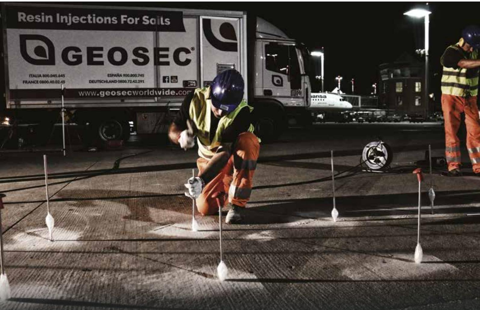
Le procédé, dans son application de base, est réalisé par le personnel spécialisé GEOSSEC® et il prévoit l'injection de résine expansive dans la structure de fondation affaissée et dans le sous dallage à renforcer. Pendant l'intervention, le contrôle continu du soulèvement est assuré par un niveau laser qui est en mesure de détecter les soulèvements au degré millimétrique.
